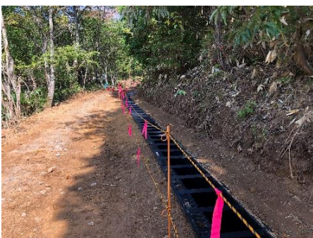
開水路敷設完了
