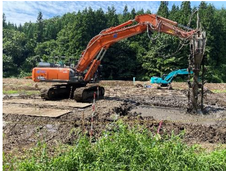
地盤改良状況
