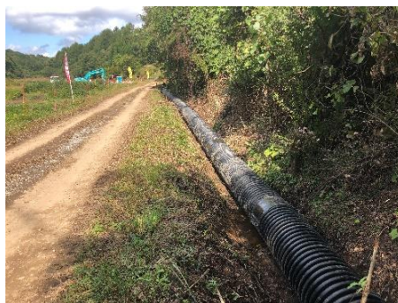
配管敷設完了
